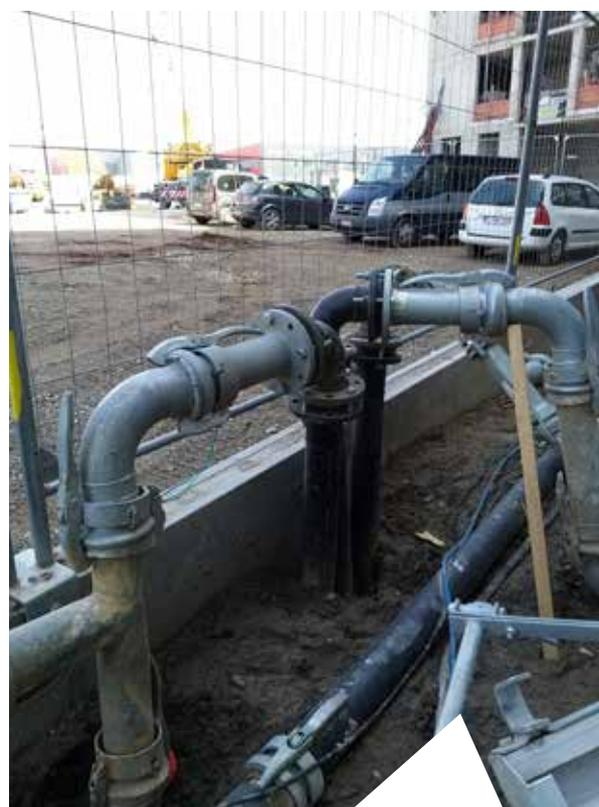
L'eau et l'énergie devenant de plus en plus rares, le quartier ou la ville circulaire de demain devra être capable de les réutiliser à bon escient. Nous réutilisons les eaux souterraines pompées sur le chantier d'AB Inbev à Louvain.
