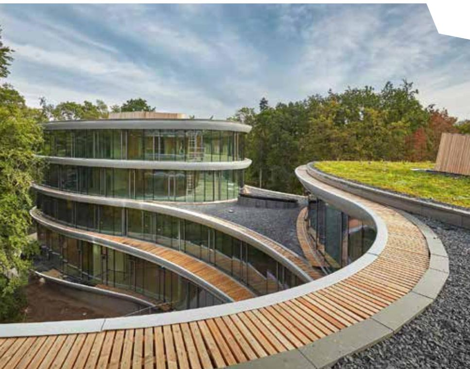
Cet immeuble de bureaux situé aux Pays-Bas est un exemple de construction circulaire: l'ensemble de la structure est assemblé de manière à pouvoir être facilement démonté.
